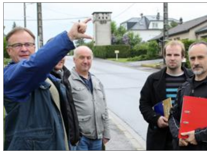
Le vieux transfo EDF de la Rue des Alouettes, entre les doigts de Jean Rebusch, a fait son temps et sera remplacé. Photo RL.
