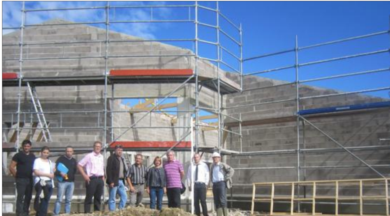
La commission municipale des travaux et un représentant des Glycines et de Théra Santé ont constaté le bon déroulement des travaux de l'unité Alzheimer. Photo RL
