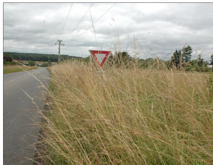
Difficile de voir les panneaux avec toute cette herbe. Photo RL
