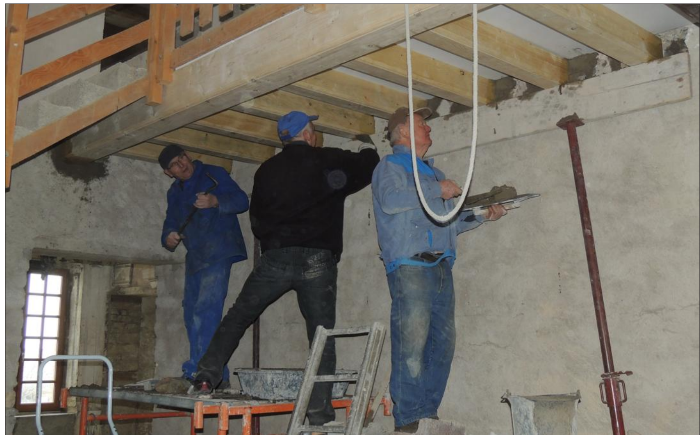
Des poutres ont été installées par les bénévoles de l'association Les amis du château sur tous les paliers de l'édifice. Photo RL
