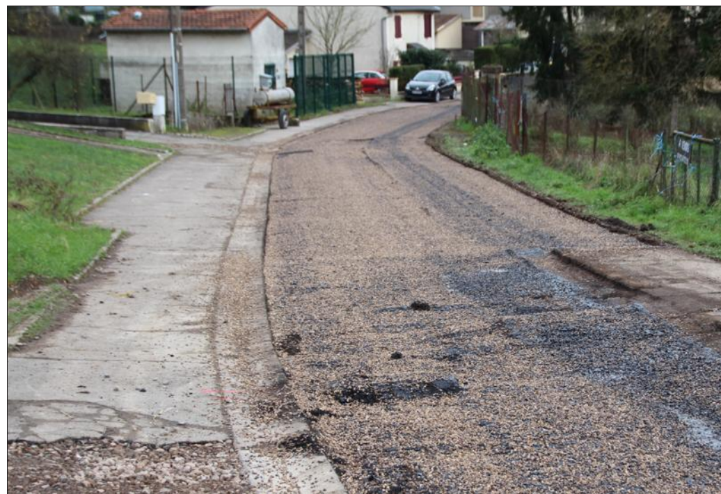
Une partie de la chaussée de la rue Haute a été refaite en enrobés. Photo RL
