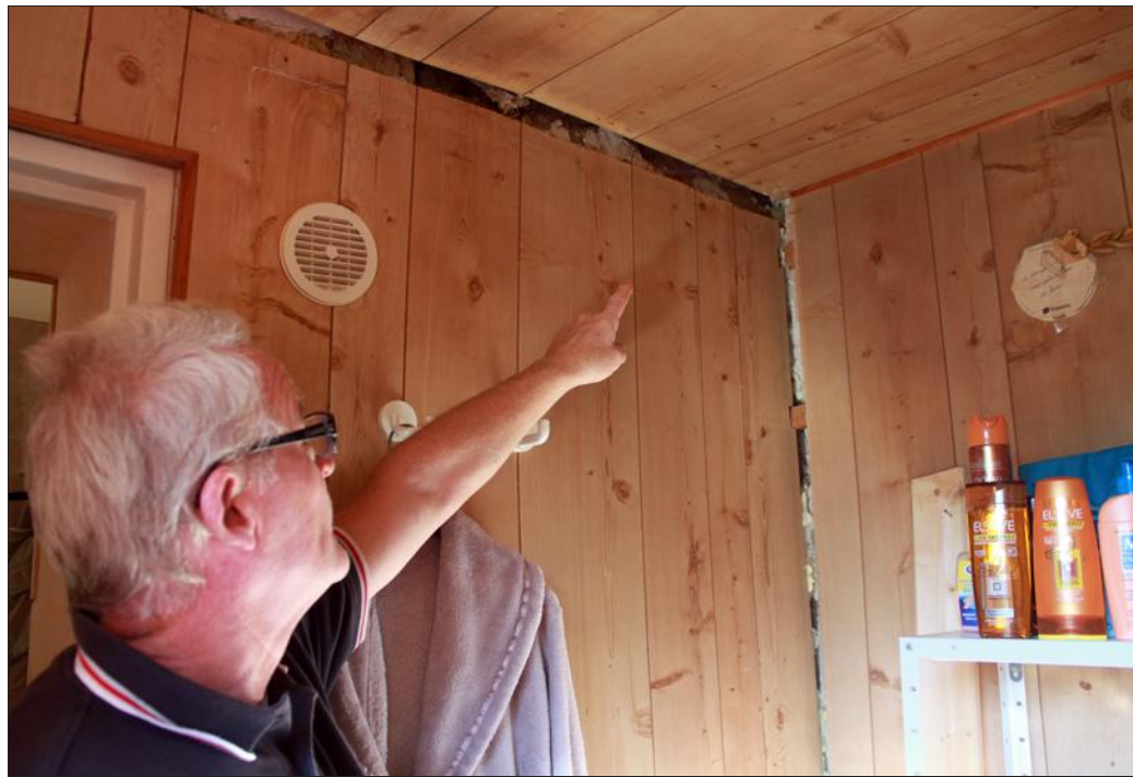
Raymond Levaux a constaté l'élargissement brutal des fissures au cours de cette année. Photo RL.
