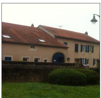
Avant d'être reloué, des travaux de rénovation doivent être entrepris. Photo RL
