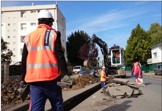
Le boulevard du Pont sera muni d'un nouveau caniveau. Photo RL
