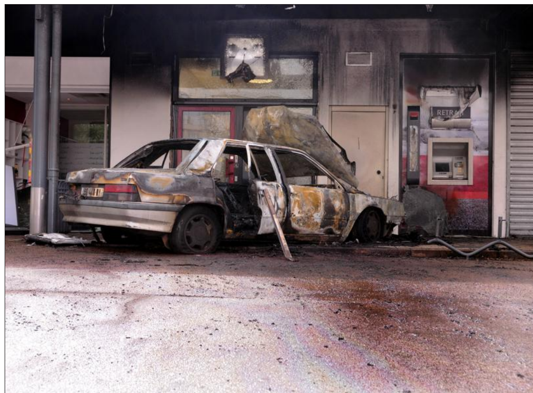
La voiture avait été volée dans le but de servir de bélier contre la façade du local du distributeur automatique. La porte blindée encastrée dans le mur n'a pas bougé. Photo Valentine COMIN
